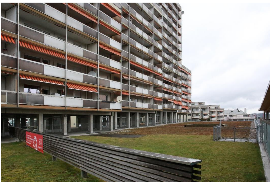
Bild 6. Das Flachdach vor den Hochhäusern wurde als neuer Standort für einen Spielplatz vorgeschlagen.
